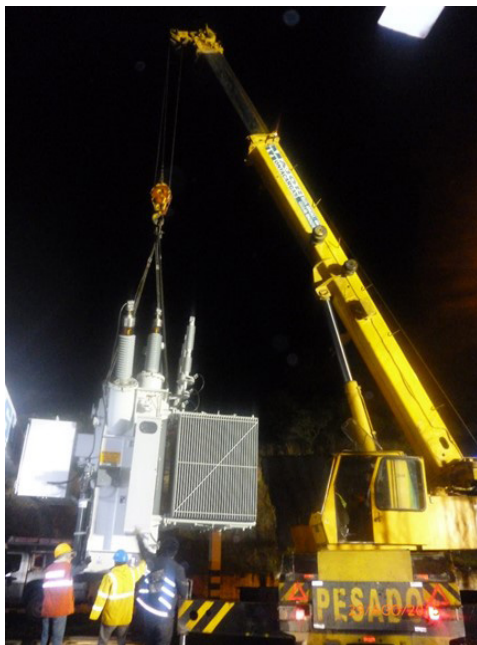
Figura 7.11. Instalación de Transformador de Potencia en la SE Norte
