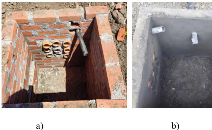
Figura 8.11. a) Construcción del pozo con ladrillo panelón; b) Revestimiento enlucido del pozo de tipo B en el proyecto.
