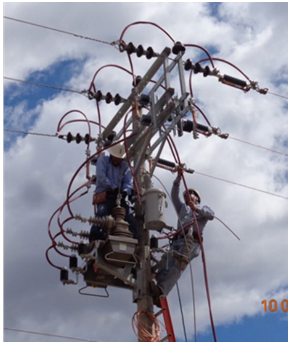
Figura 7.13. Cuadrilla de línea energizada de la EERSSA
