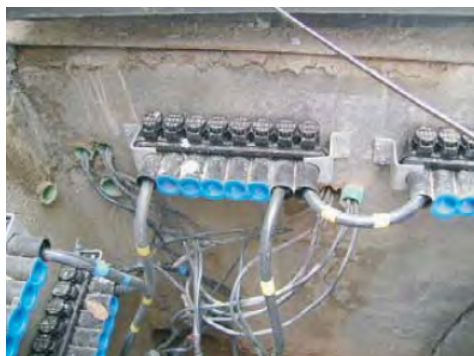
Figura 8.10. Barrajes en Gel para redes de BT y AP. Fuente: Iriarco (2023).
