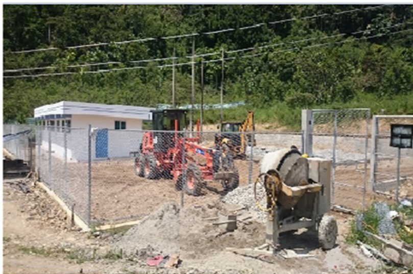
Figura 7.12. Construcción de la nueva SE Yantzaza
