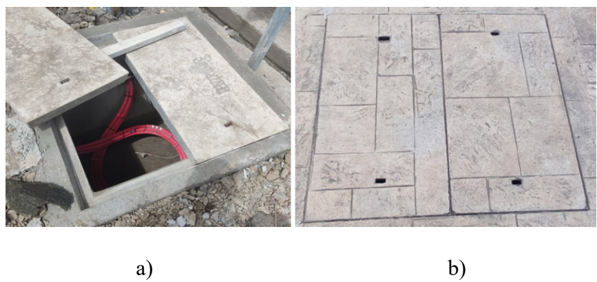
Figura 8.12. a) Tapas en etapa gris de construcción; b) Tapas del tipo B en el proyecto con revestimiento en cerámica.
