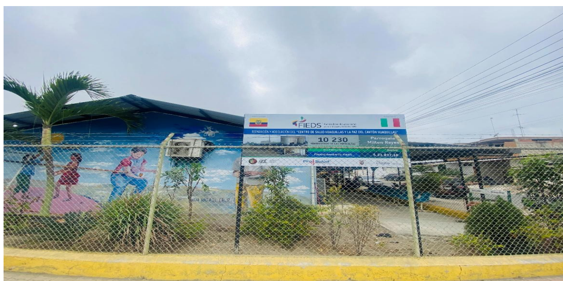
Foto 3. Readecuación física del Centro de Salud Huaquillas y la Paz cantón Huaquillas.
