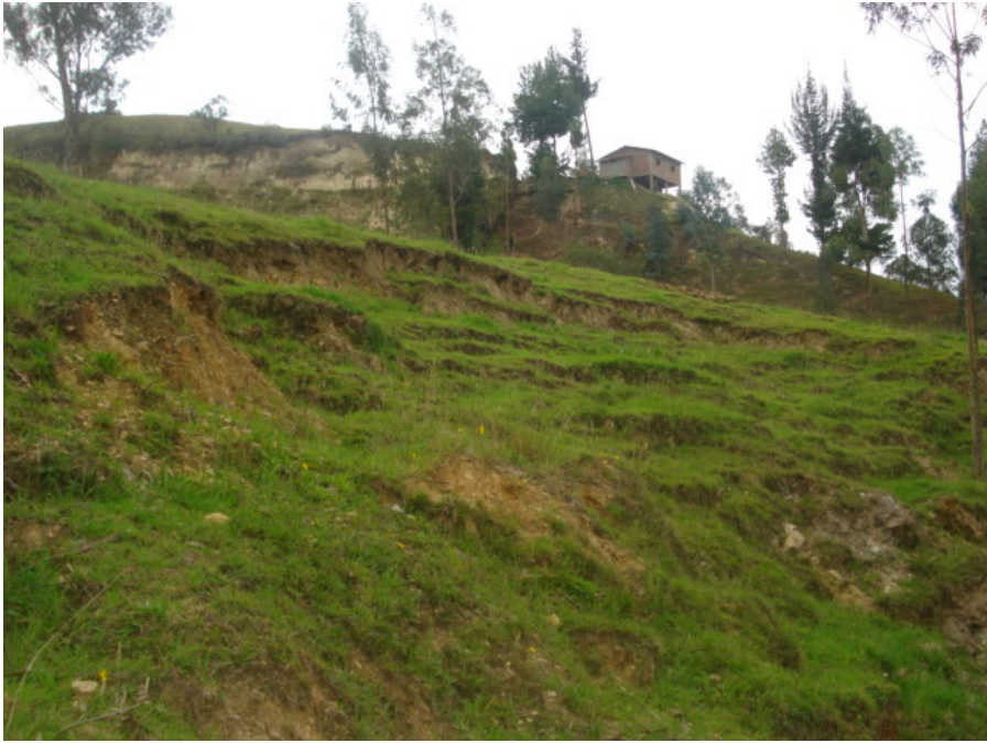
Figura 3. Deslizamiento en masa en el área de Salapa del Sistema de Riego Santiago. Fuente: Bastidas y Coronel (2014)
