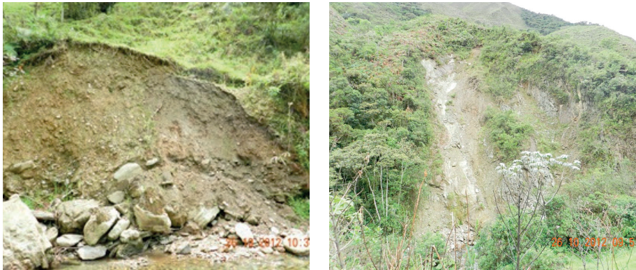
Figura 3. Evidencias de deslizamientos de tierra en la microcuenca Jipiro
